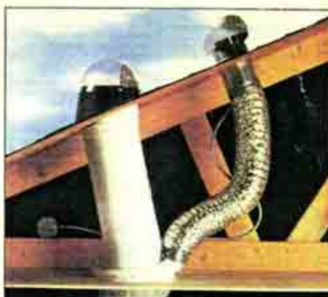
A la izquierda, un tragaluz tubular que incorpora, además, luz artificial. A la derecha, otro con ventilación.
